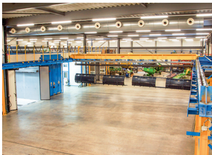
Der Landtechnikhersteller Zürn hat jetzt ein hochmodernes Oberflächenzentrum in Betrieb genommen.
